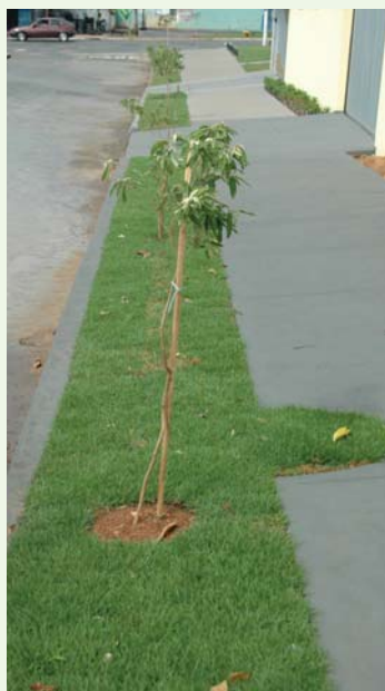
Figura 101. Exemplo de calçada ecológica. Nota-se a adaptação das raízes na calçada com a abertura permeável.
