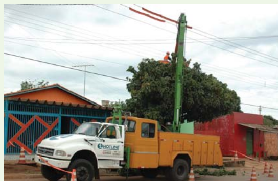
Figura 114. Equipe realizando poda em rede convencional em condutores elétricos secundários.
