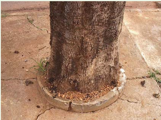
Figura 95. Plantio inadequado, realizado dentro de uma manilha que possui espaço insuficiente para o crescimento do sistema radicular. Observa-se o início de rachaduras na calçada
