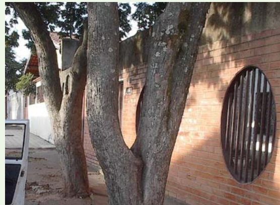
Figura 85. A imagem mostra o erguimento da calçada ocasionado devido ao plantio da espécie inadequada e também pela insuficiência da abertura permeável onde está plantada a árvore.
