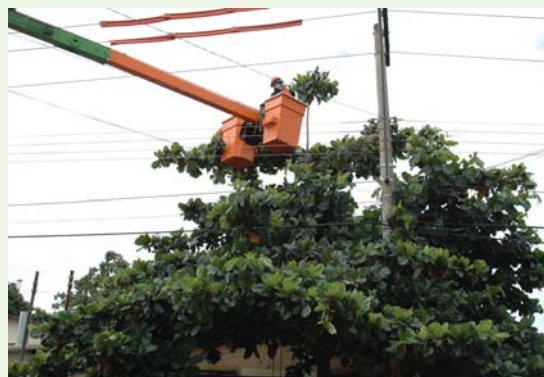
Figura 112. Equipe realizando poda em rede convencional BT e AT.
