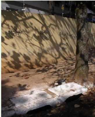
Figura 99. Plantio inadequado realizado junto aos bueiros.
