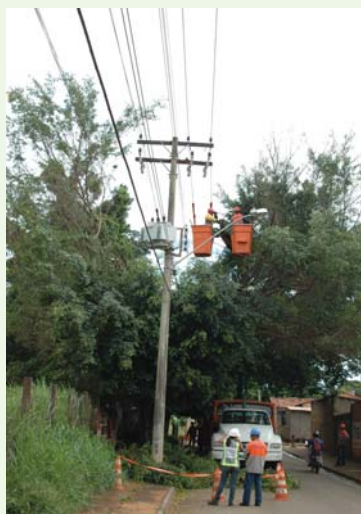
Figura 113. Equipe realizando poda em rede convencional de alta tensão.
